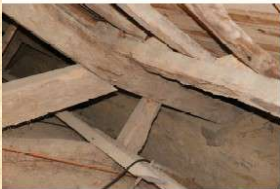
3- Dégradation courante des arbalétriers, due à une mauvaise reprise des efforts de traction par l'entrait retroussé.
