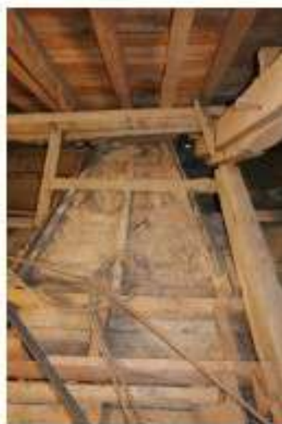
4- Pénétration de voûte par le châssis de toit de la nef (travée B)
