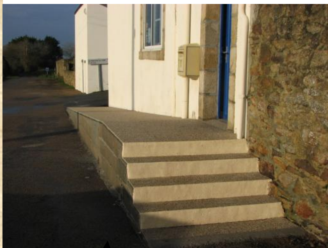
Mise aux normes handicapés de l'accès à la poste L'accès à la mairie sera réalisé en 2010
