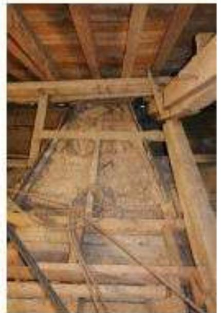
4- Pénétration de voûte par le châssis de toit de la nef (travée B)
